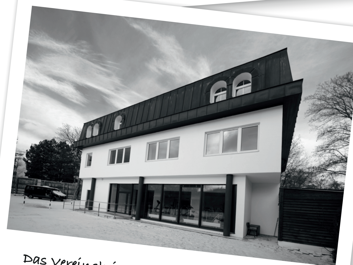
Das Vereinsheim nach der Generalsanierung
